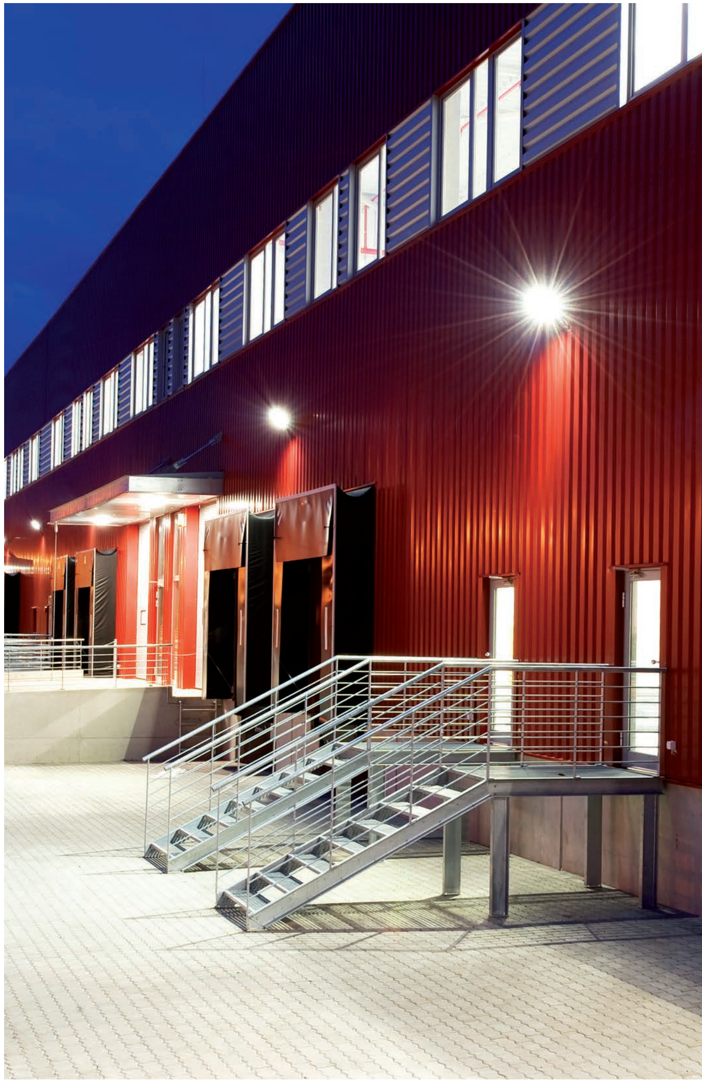
125 proiettori da esterno / outdoor floodlights
