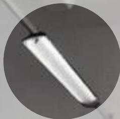
Installazione dell' Inverter Plug&Light su apparecchio BS100 LED all'interno di un magazzino. Questa soluzione evita la collocazione di ulteriori apparecchi di emergenza e assicura un ottimo livello di sicurezza specie in funzione dell'elevata altezza di installazione: il grande flusso in emergenza ottenuto dalle BS100 LED garantisce un ottimo illuminamento a suolo in caso di blackout anche da 10 m di altezza.
