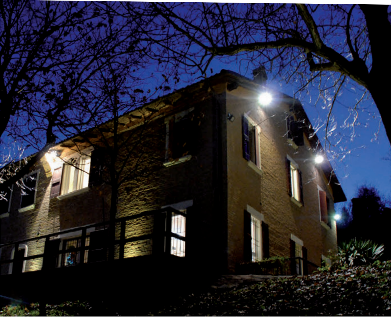
135 proiettori da esterno / outdoor floodlights
