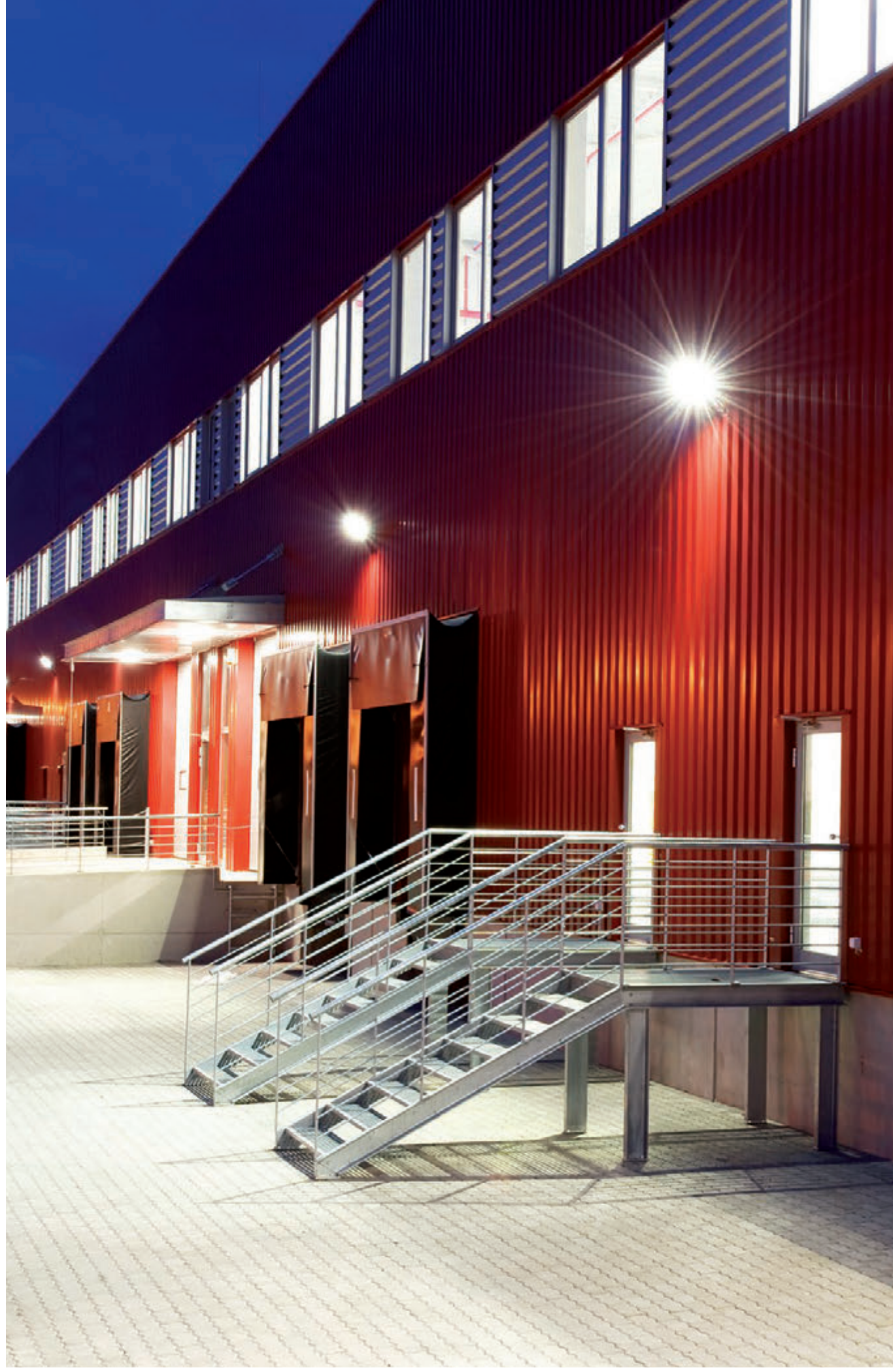
125 proiettori da esterno / outdoor floodlights
