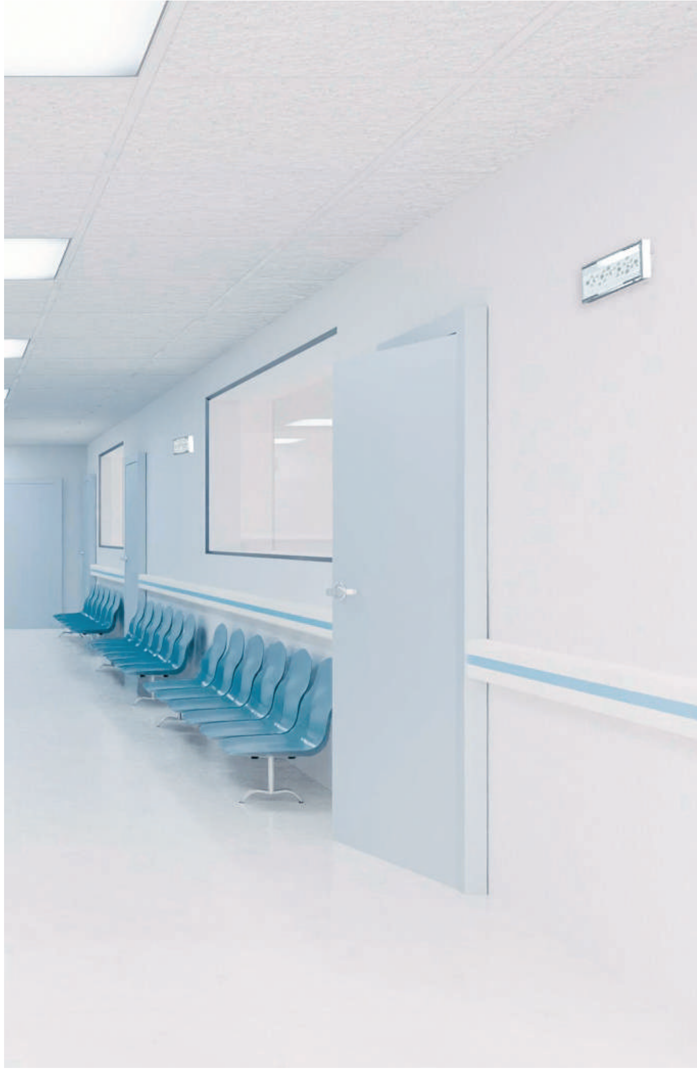
031 oprawy oświetlenia awaryjnego
