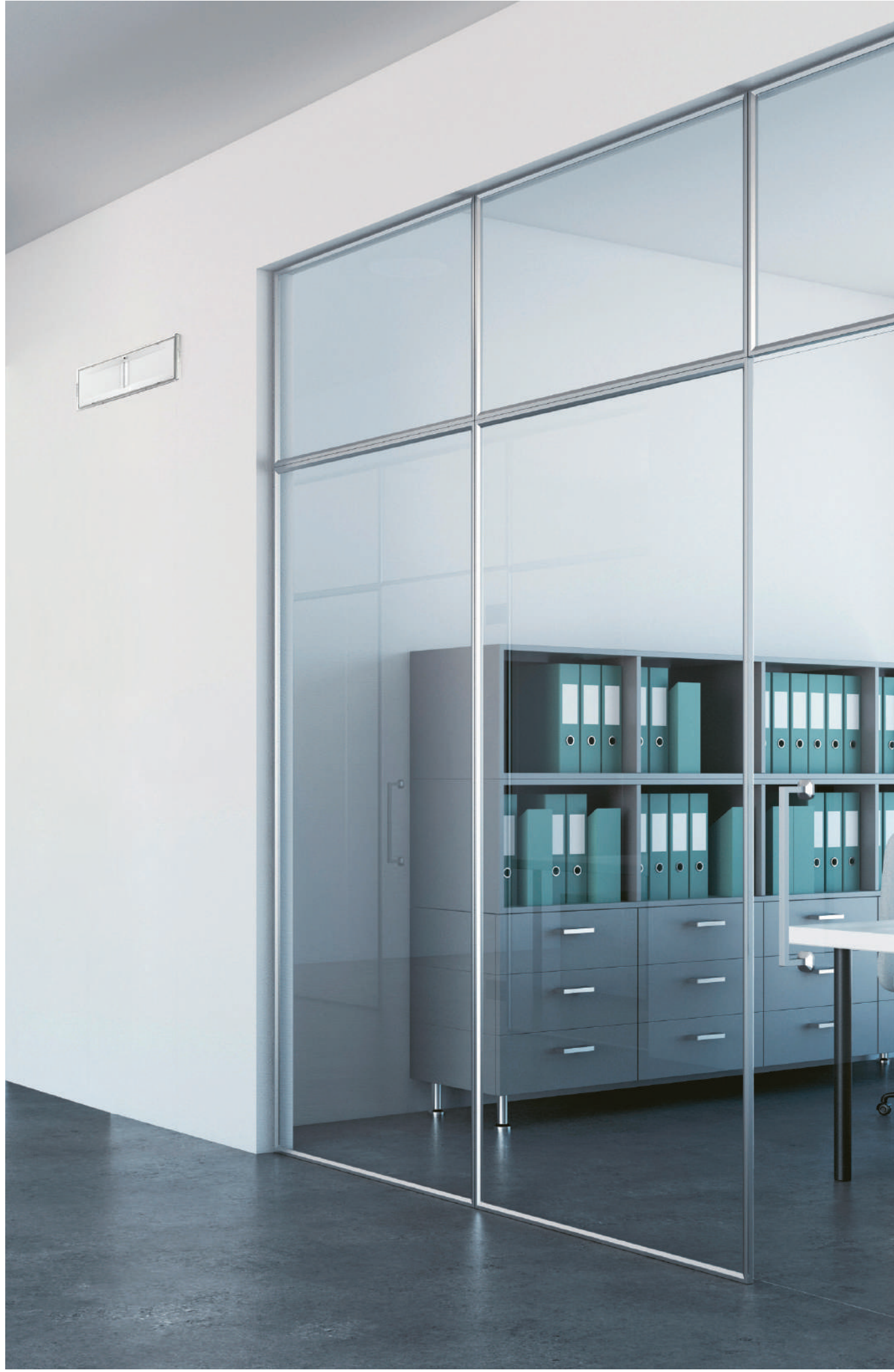
043 oprawy oświetlenia awaryjnego
