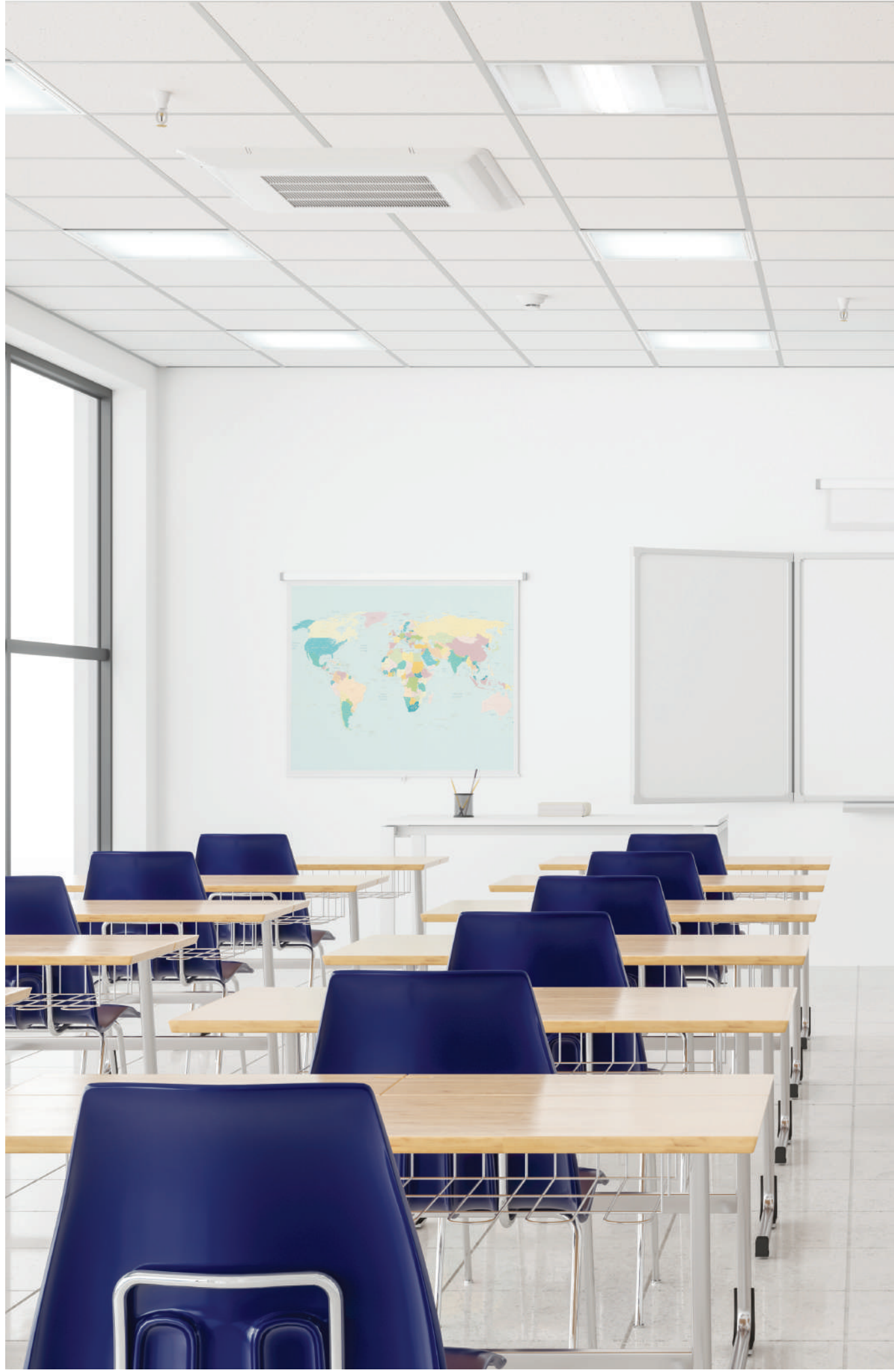
017 oprawy hybrydowe z systemem odkazającym powietrze
