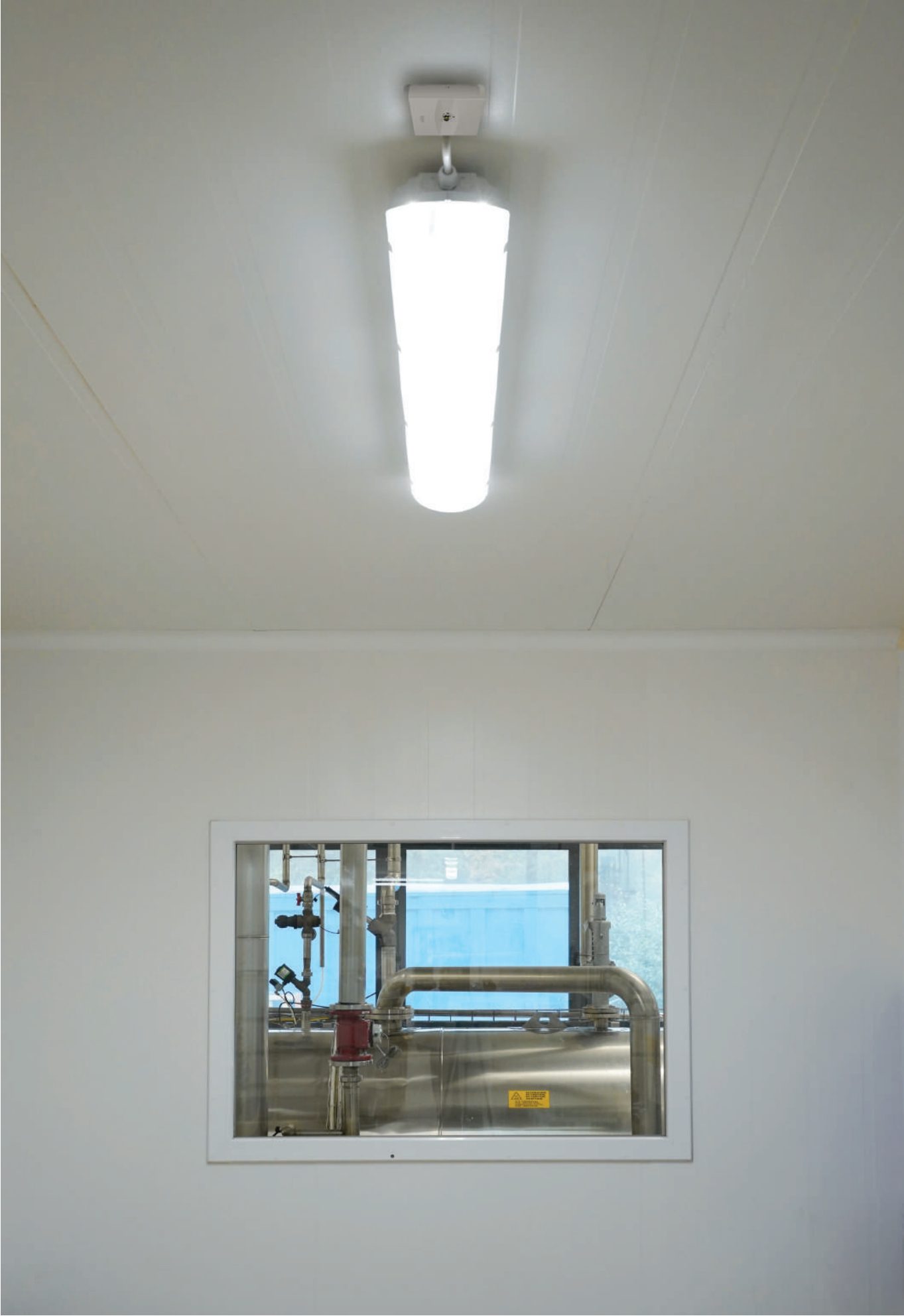
049 kompaktowe oświetlenie awaryjne / spotlights
