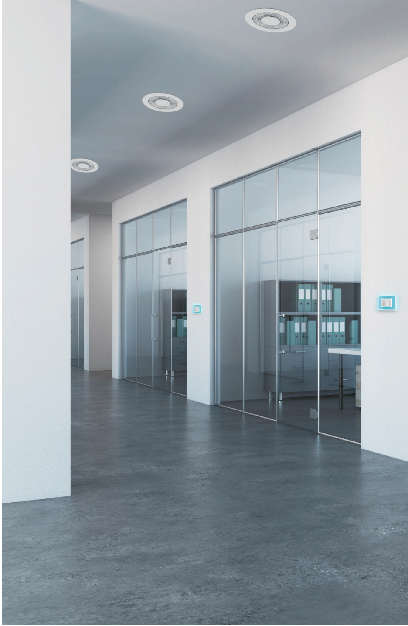
055 oprawy typu downlight
