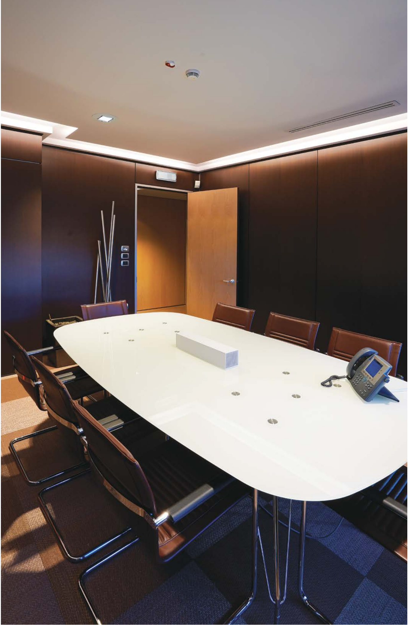
oprawy oświetlenia awaryjnego
