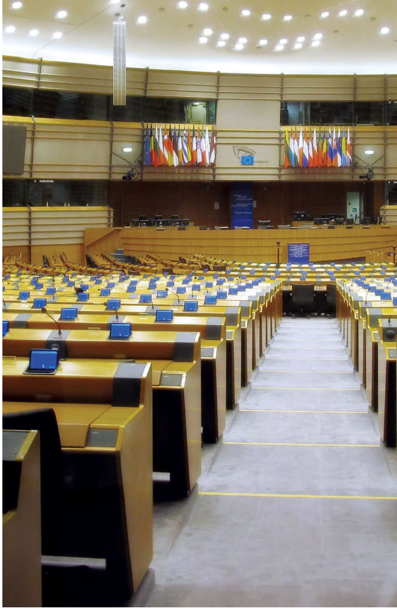
027 oprawy oświetlenia awaryjnego
