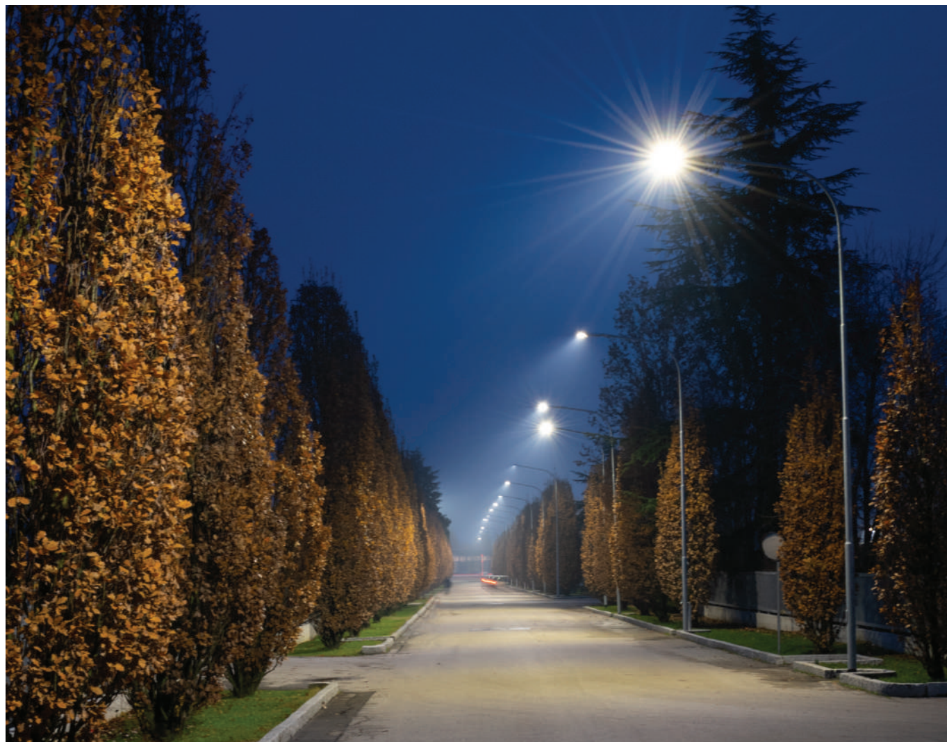
oprawy uliczne / street lighting
