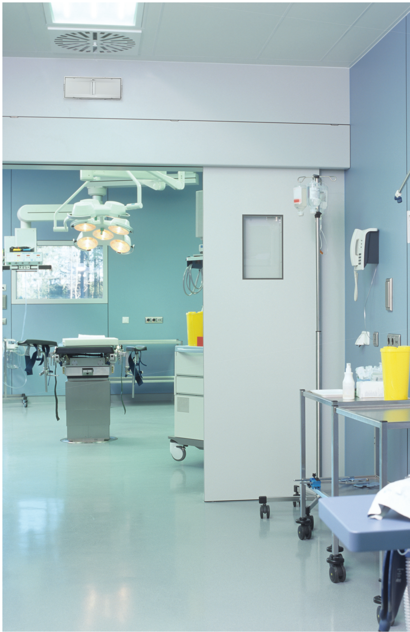
oprawy oświetlenia awaryjnego / luminaires
